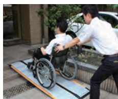
家屋周辺の段差解消
